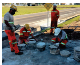
SERVIÇOS DE PAVIMENTAÇÃO
