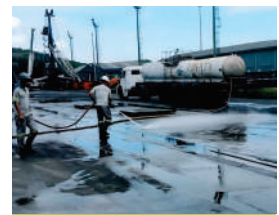
LAVAÇÃO DE CAIS
