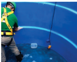
LIMPEZA DE CAIXAS D'ÁGUA
